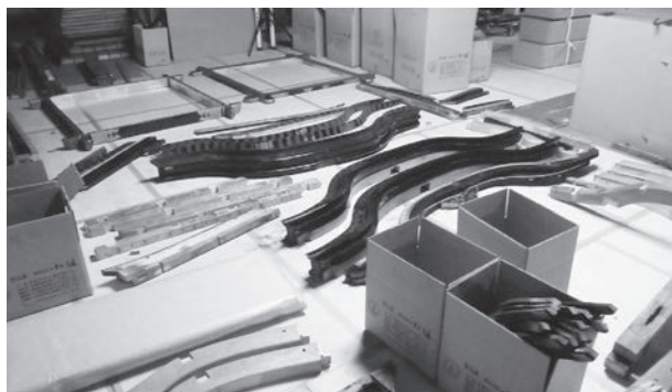
解体された下層屋根と柱等の胴体部分
