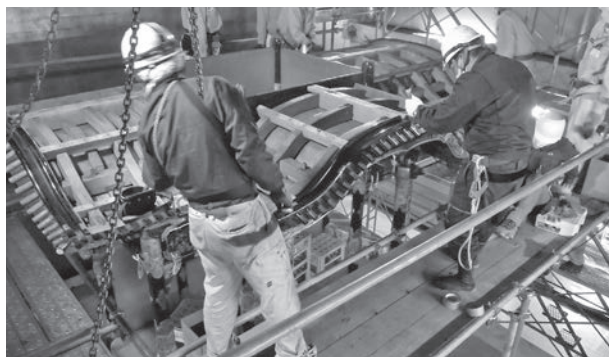
少しずつ下層屋根が解体されていきます
