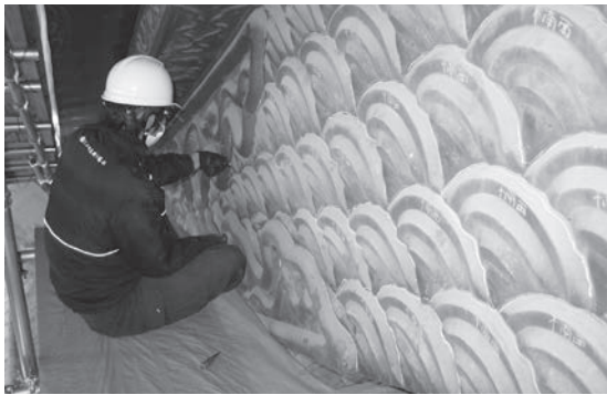
金物を取り外す前の確認作業
