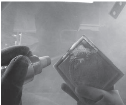
ショットブラストにより錆などの汚れを除去中
