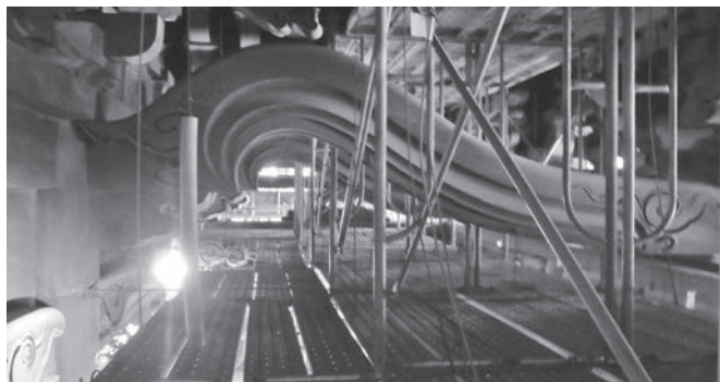
海老のように曲がっていることから「海老虹梁」と呼ばれています
