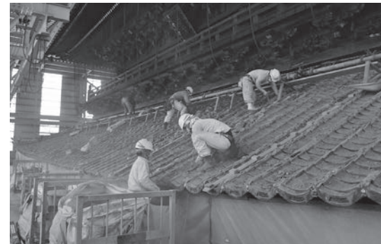
瓦降ろし作業の様子
