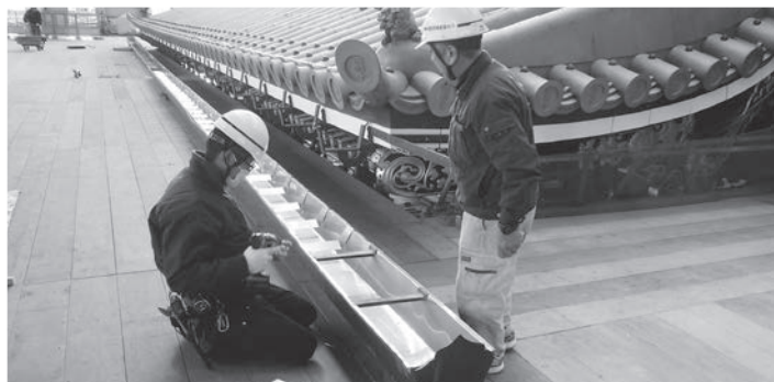
樋を取り付ける前
