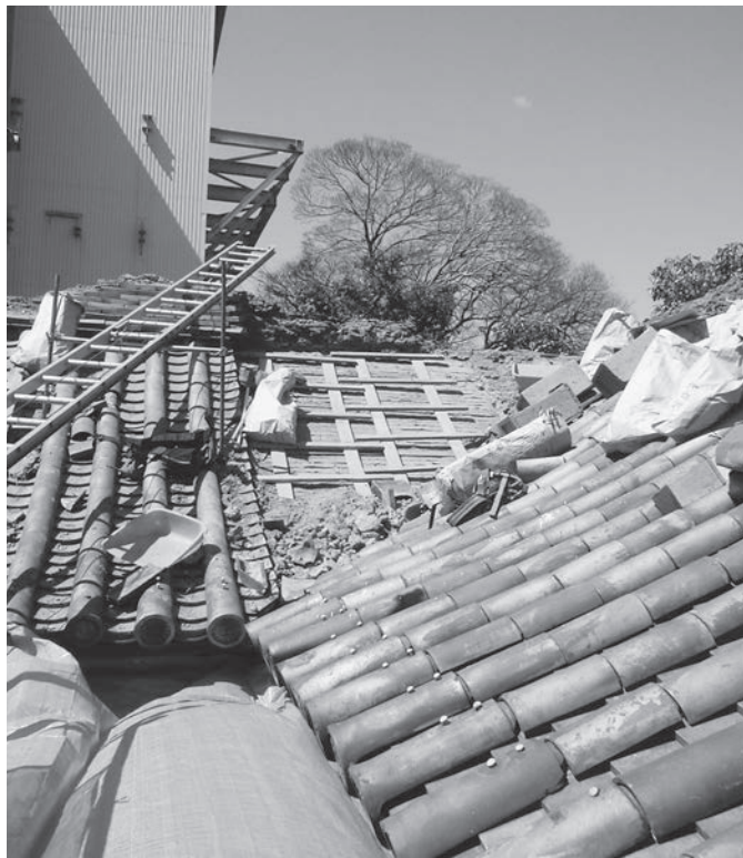
瓦を降ろした様子
