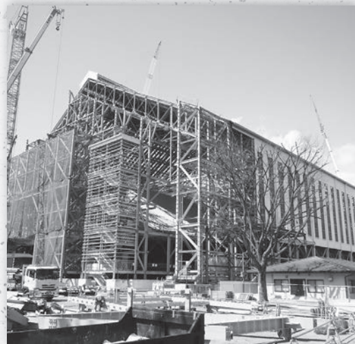
阿弥陀堂南東側から見た素屋根
