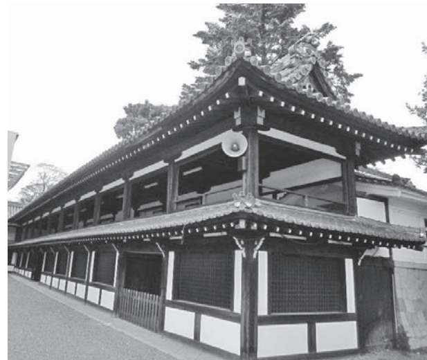
修復前の高廊下
