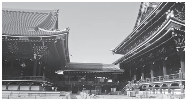
両堂間のエレベーターとトイレを改修しました
