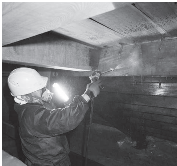
溶剤を噴射する作業の様子
