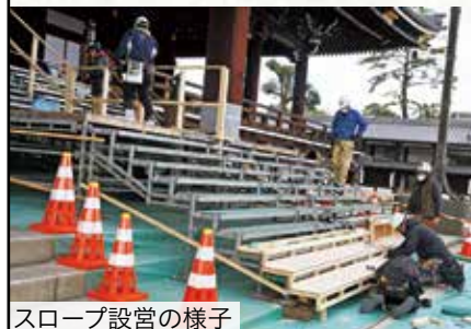
スロープ設営の様子
