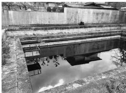
本願寺水道水源池
