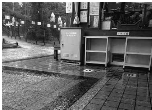
祖廟事務所前の水溜まり
