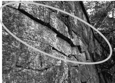
御廟所内の擁壁
