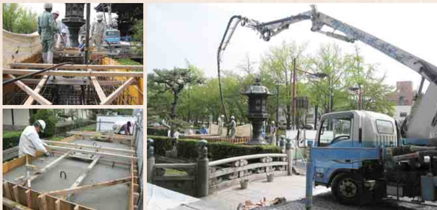
境内〈外〉 [右] 離れた場所はポンプ車を使って生コンクリートを流し込みます [左上] 杭と鉄筋の型枠内に生コンクリートを投入 [左下] 流し込まれた生コンクリートを手作業で均して固めます
