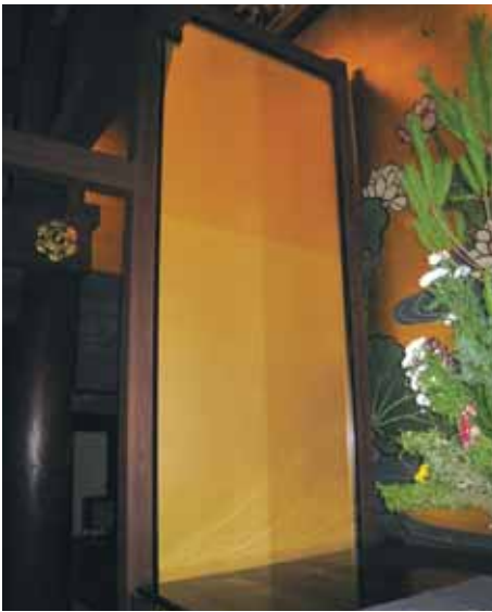
[上] 改修工事の様子 [左] 金紙貼りが施された仮設板壁
