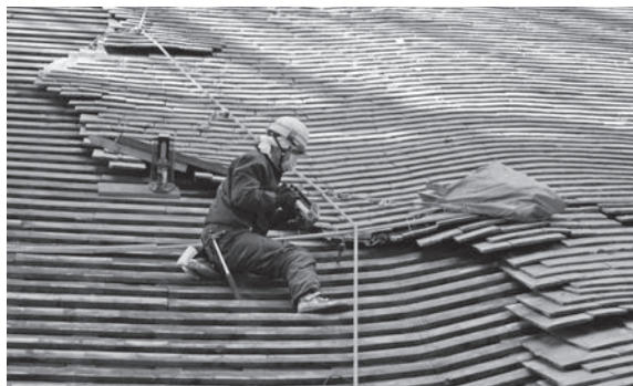
土居茸板をジャッキアップしながら、一枚一枚丁寧にめくっています
