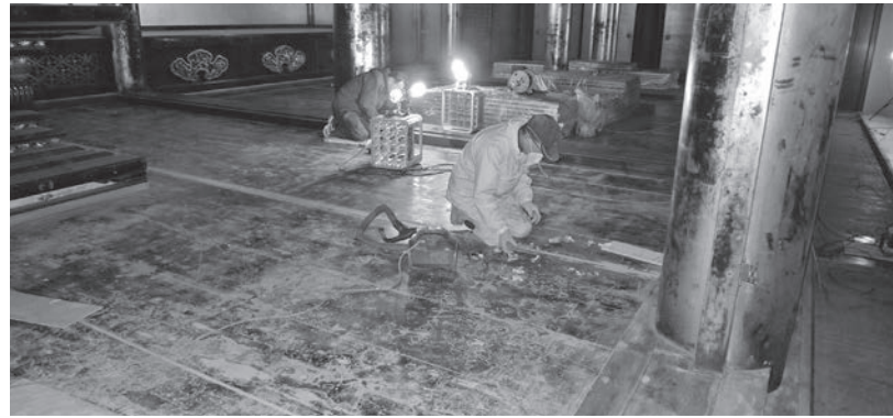
阿弥陀堂内陣での作業の様子
