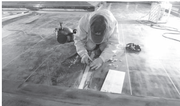
内陣本間を縦断する大きな亀裂には檜板で「埋木」します
