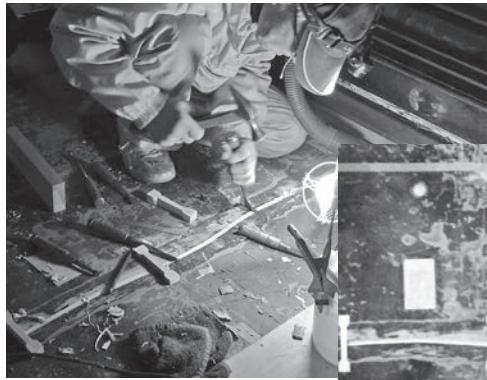
←「ちぎり」を埋め込む作業の様子
