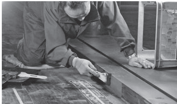
敷居は一部、下地作業が始められています
