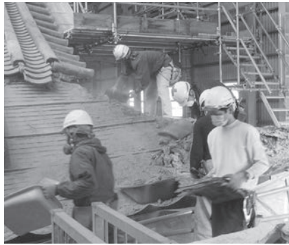
瓦降ろし作業の様子
