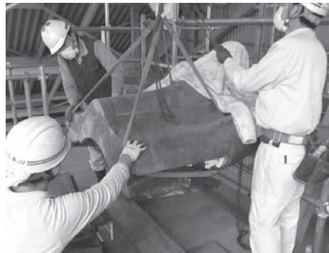
大棟獅子口最上段の瓦は鎖で吊り上げて降ろします
