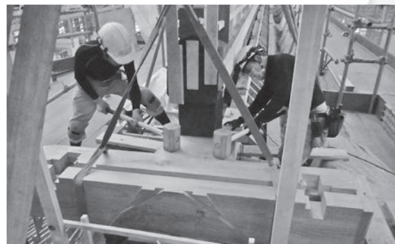
鬼台(大棟の先端にある「獅子口」を支える台)を取り付けています
