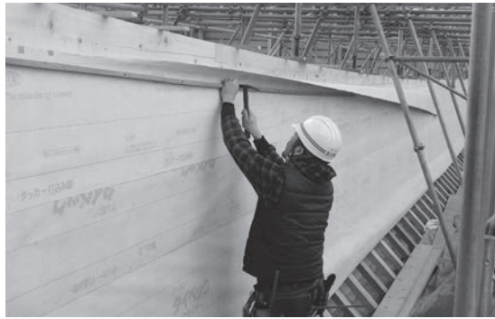
ルーフィング(透湿防水素材の特殊シート)の大棟下地への取り付け作業
