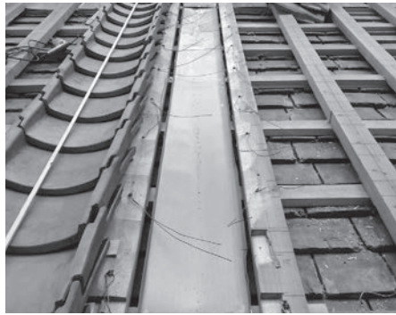
設置されているチタン亜鉛合金板(中央)
