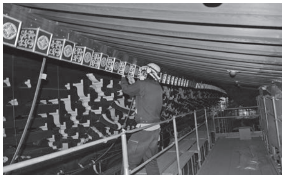
垂木鼻鍍金物の取り付け
