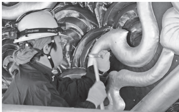
阿弥陀堂破風への鍍金物の取り付け
