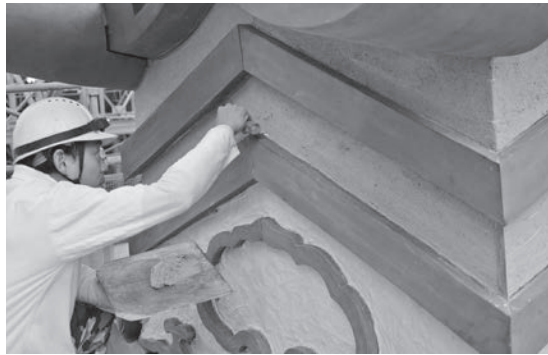
漆喰を塗りこむ左官工事
