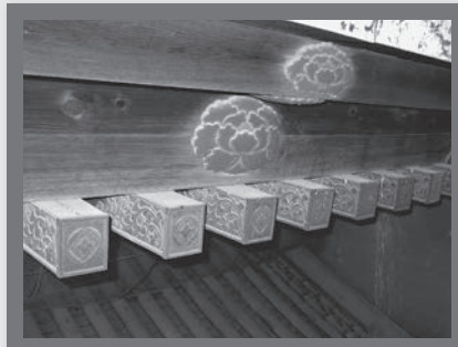
修復前の垂木鼻鋳金物
