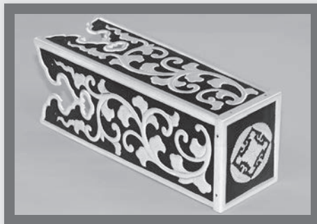
修復後の垂木鼻鋸金物
