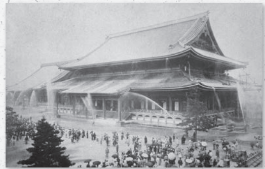
両堂放水試験写真
