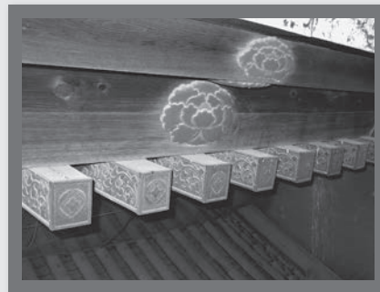
修復前の垂木鼻鋸金物
