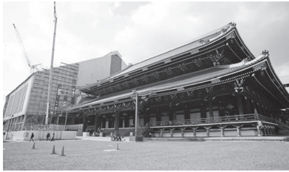
御影堂側から見た素屋根
