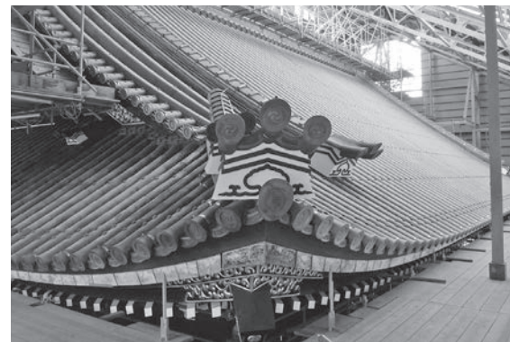
瓦葺きを終えた屋根瓦(上:上層部、下:下層部)
