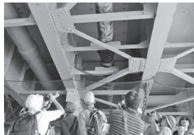
本願寺水道の配管を見学(五条大橋の下)
