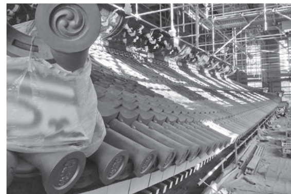
瓦葺きを終えた屋根瓦(上:上層部、下:下層部)
