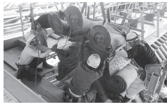
獅子口瓦を設置
